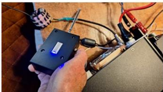
Mantelstroom filter, sniffer aan de uitgang van het filter.... Géén spanningsmaximum meer....
